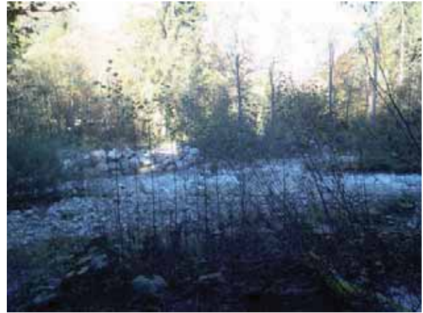
Protections de berges en enrochements libres (Aval du secteur à restaurer)
