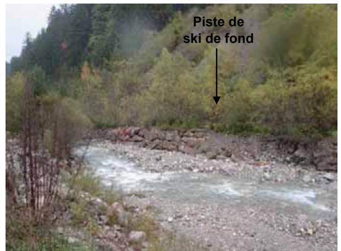
Protections de berges en rive droite du torrent de Seytroux
