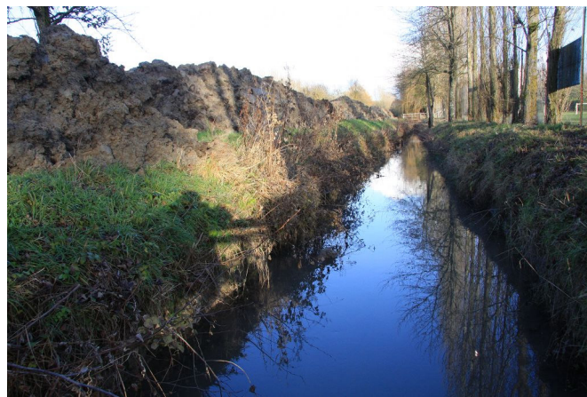
Recalibrage d'un cours d'eau
